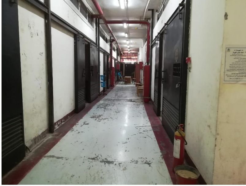
صورة لمدخل الورش الهندسية بالمبنى الفرعى بالخلفاوى.
